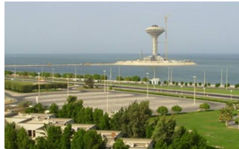
الشكل رقم (٣٩). خزان المياه.
