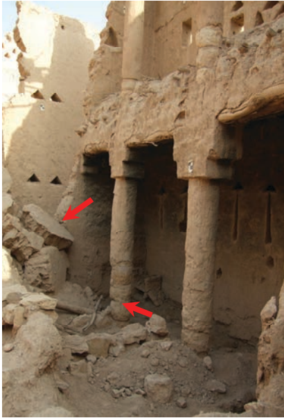
الصورة رقم (٢٢). تهدم الجدار الخارجي ناحية الشمال للسبالة وتآكل السطح الخارجي لخز العمد السفلي.
