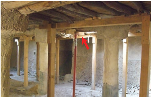
الصورة رقم (١٧). جدار القبلة بالخلوة وتلف السقف ودعمه بالقوائم الخشبية.
