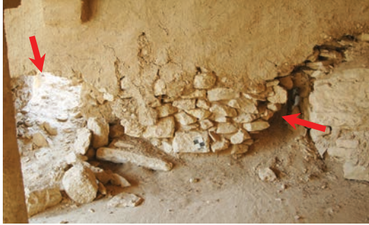
الصورة رقم (١٣). صورة مقربة للجزء السفلي من الجدار الجنوبي من المسجد توضح تآكل طبقة الملاط وتفكك مداميك الأحجار السفلية بالجدار مع تكون فتحات نافذة بأسفل الجدار.
