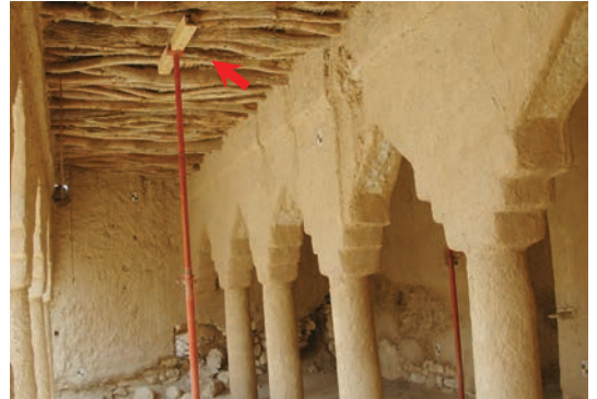
الصورة رقم (١٠). مصابيح المسجد من الداخل ويظهر الحالة المتدهورة لطمايم السقف من جذوع الأثل وتلف الجدران.
