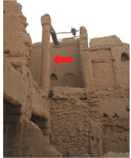
الصورة رقم (٢١). الركن الجنوبي الشرقي من السبالة، سقوط السقف جعل العمود حر من أعلى مما يجعله غير آمن إنشائياً وقابل لانهار لضعف تثبيته من أسفل.
