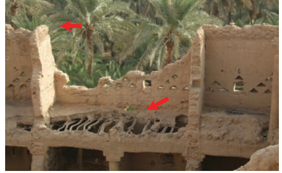
الصورة رقم (١٩). تهدم جدران الطابق الأول بالجانب الشرقي من السبالة وتساقط معظم الكسوة الطينية للسقف مع ميل الجدار الأيسر.
