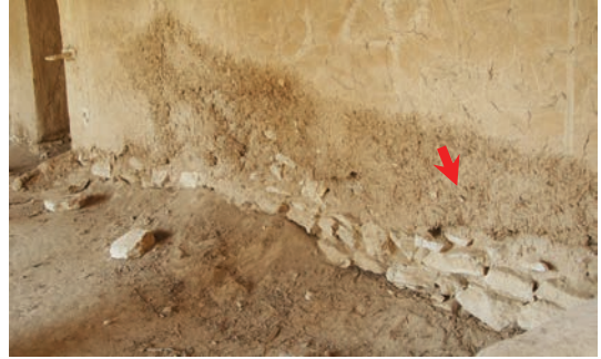
الصورة رقم (١٢). صورة مقربة للجزء من جدار القبلة توضح تآكل طبقة الملاط وتفكك مداميك الأحجار السفلية بالجدار.
