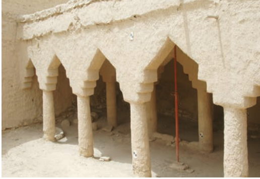
الصورة رقم (٩). واجهة مصابيح المسجد ذات الرؤوس المدببة من تشكيل أحجار الطبقة والأعمدة الدائرية والتيجان أعلاه.
