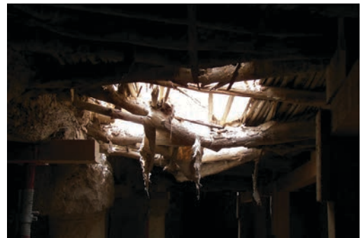
الصورة رقم (١٦). انهيار جزئي بسقف خلوة المسجد ودعم باقي السقف.
