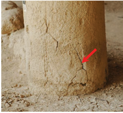
الصورة رقم (١٥). الجزء السفلي من عمود آخر يوضح شروخاً وتفككاً في ملاط الطين بسطح العمود.
