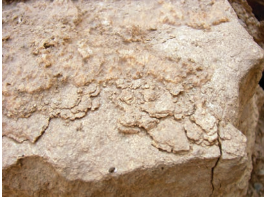
الصورة رقم (٤٠-أ، ب). التكلسات الملحية وانفصال الطبقات السطحية لأحجار مسجد وسبالة موزي.
