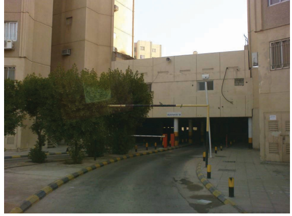
الشكل رقم (٢٣). البوابات الآلية لأحد مواقف المشروع.
