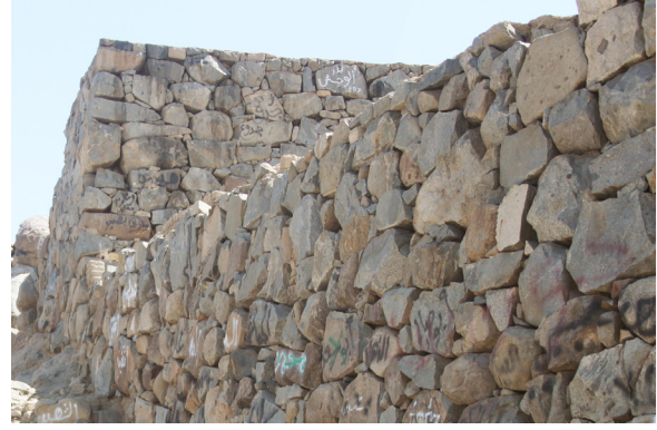
الصورة (٤): جزء من الحوائط الصخرية الساندة بدكة بافيل (عدسة الباحث).
