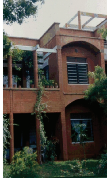
شكل ١٠- شكل ١١: أبنية مشيدة من البلوك المنتج بالماكينات اليدوية التشغيل المصدر: www.aureka.com
