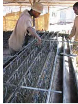
شكل ٢٧: صب طبقة الخرسانة في القوالب
