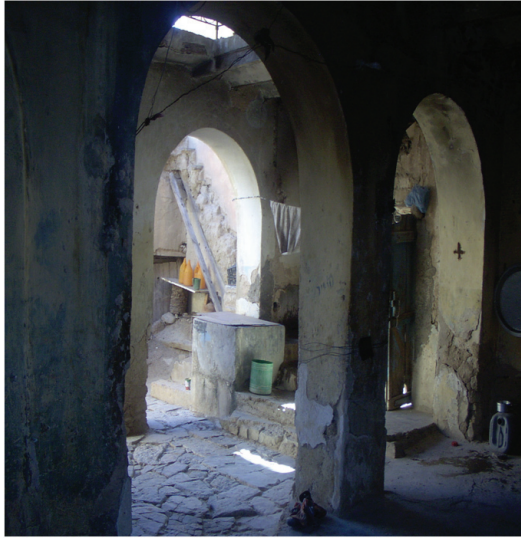
الشكل (٤) - تدهور الظروف المعيشية للسكان نتيجة قدم الإطار المبنى. المصدر: من إنجاز الباحث ٢٠٠٦
