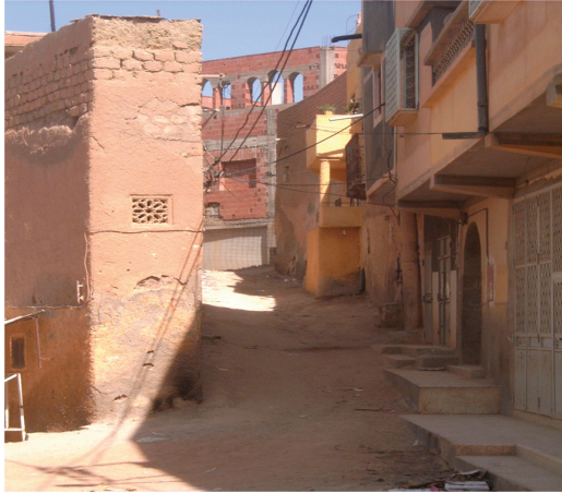
الشكل (٦) - تناقض الطابع المعماري بين الأبنية القديمة والحديثة . المصدر: من إنجاز الباحث ٢٠٠٦
