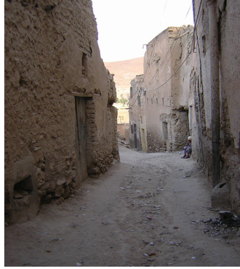
الشكل (٢) - الحالة الفيزيائية المتدهورة للإطار المبنى
