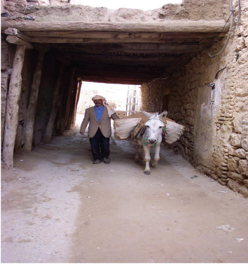
الشكل (٨) - تدهور وضعية السقائف وجميعها مهددة بالانهيار. المصدر : من إنجاز الباحث . ٢٠٠٦
