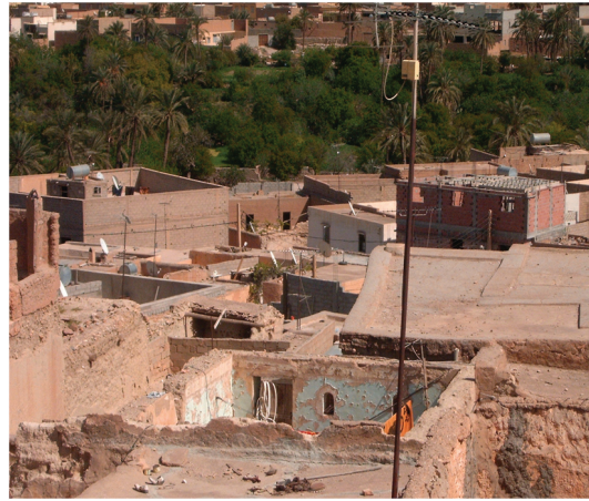
الشكل (٥) - عمليات البناء والتجديد داخل القصر تتم بطرق غير مدروسة ودون رخص بناء
