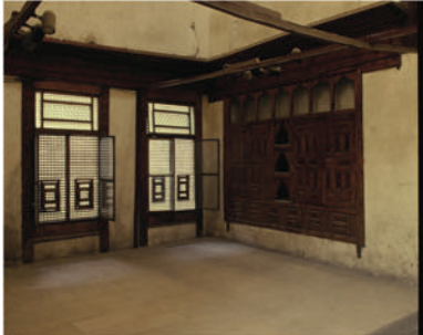
شكل ( ٥ ) ارتفاعات الداخل التي تجاوزت الأبعاد الإنسانية المعتدلة في سقوف والايونات ، و كسر الارتفاع عن طريق وضع بروزات خشبية عند الارتفاع المناسب للمقياس الإنساني.
