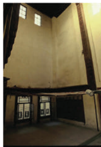
شكل ( ٥ ) ارتفاعات الداخل التي تجاوزت الأبعاد الإنسانية المعتدلة في سقوف والايونات ، و كسر الارتفاع عن طريق وضع بروزات خشبية عند الارتفاع المناسب للمقياس الإنساني.
