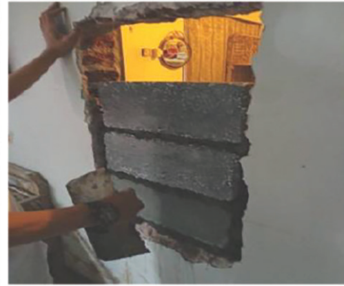
الشكل رقم (٨). صورة المنتج النهائي لاستخدام الستاير وفوم وقصب السكر بالخرسانة - المرجع (Setyowati,2014).
