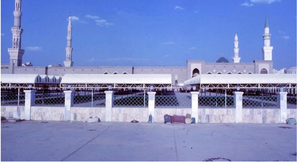
الشكل (٧) المظلات الحديدية غرب المسجد النبوي ، صيف ١٩٧٦م. المصدر : الباحث
